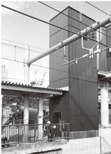
某駅のエレベーター設置工事
