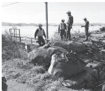
堤防より低い越後線鉄橋での越水を防ぐ作業(大河津分水路)
