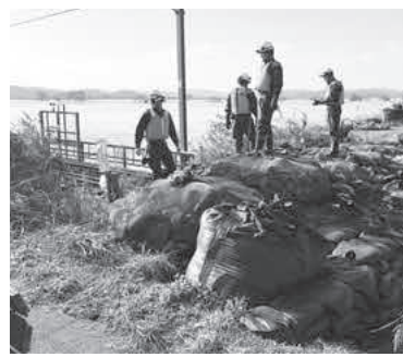
堤防より低い越後線鉄橋での越水を防ぐ作業(大河津分水路)
