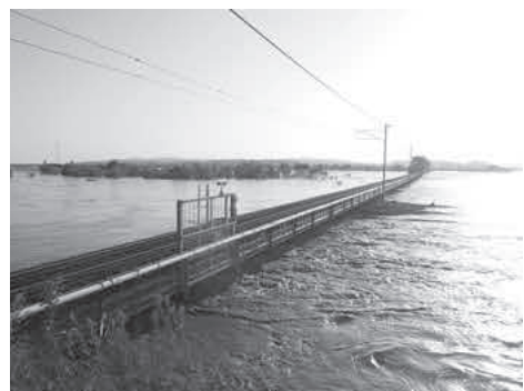
最高水位 17.06 m を記録した大河津分水路
