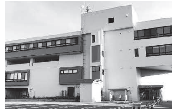
その活用が期待される「駅チカマチナカ」施設の燕庁舎
