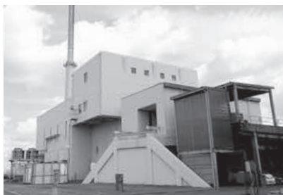
環境に配慮し安全、安定したごみ処理を実施
