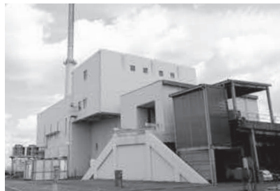
環境に配慮し安全、安定したごみ処理を実施
