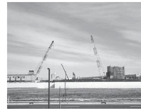
建設が進む県立基幹病院
