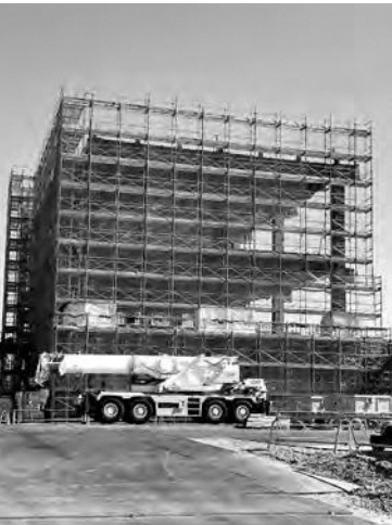
鉄骨が組み始めた県央基幹病院
