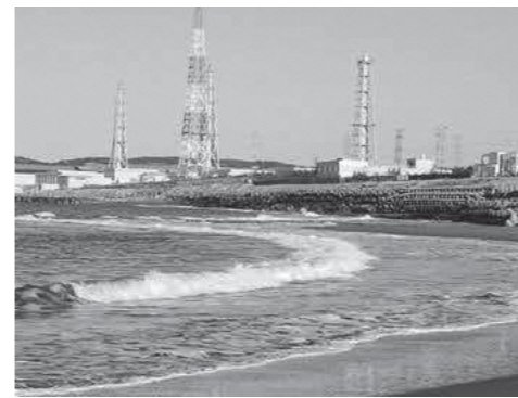
柏崎刈羽原子力発電所
