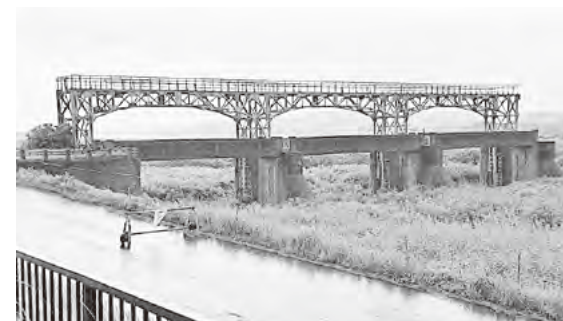
越後平野の守り神、旧可動堰を含めた公園の周辺整備
