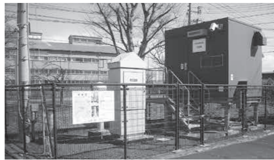
分水公民館敷地の放射能モニタリングポスト。地震時、石川県では一部が通信不能被害に
