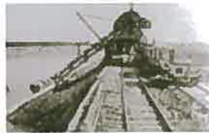
水路を掘る機械 エキスカベータ
