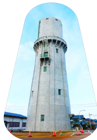
燕市旧浄水場配水塔（水道の塔）
