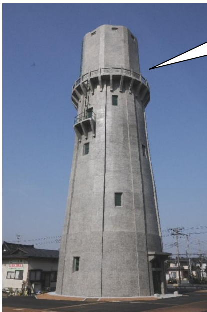
改修した水道の塔（平成 24 年 4 月撮影）
