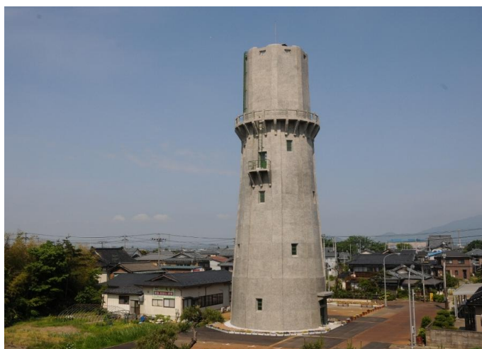
配水塔全景（東から）
