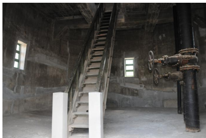
配水塔 1 階内部
