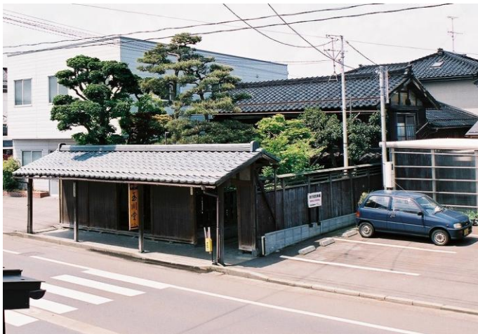
玉川堂店舗（旧主屋）
