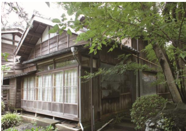
今井家住宅新座敷 外観（東側）
