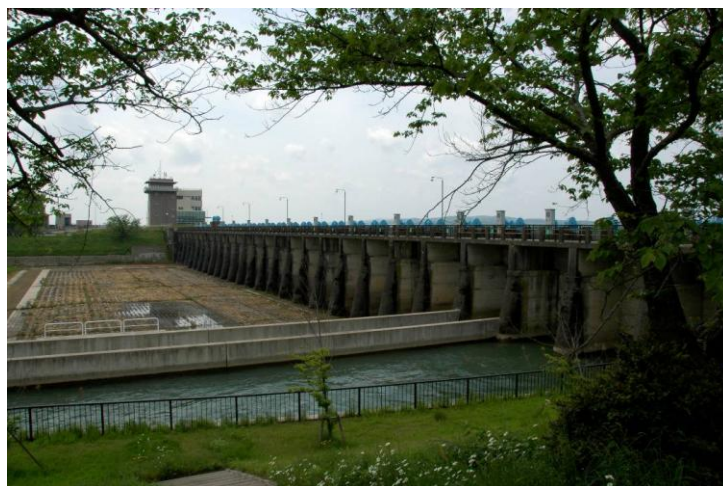
洗堰 全景（南東から）
