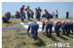
シート張り工
