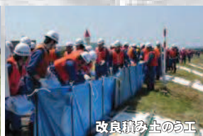
改良積み土のう工
