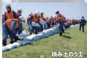
積み土のう工
