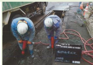
【コンクリート取壊工】
