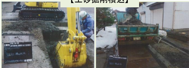
【土砂掘削積込】
