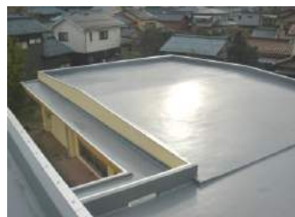
施工後(屋上防水)
