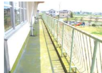
着工前(ベランダ防水)
