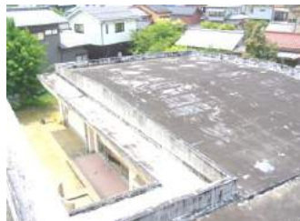
着工前(屋上防水)
