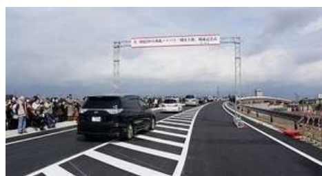
平成 31 年 3 月に開通した国道 289 号 燕北バイパスの「朝日大橋」
