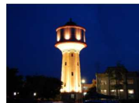
【ライトアップ事例】 (長岡市旧中島浄水場配水塔)
