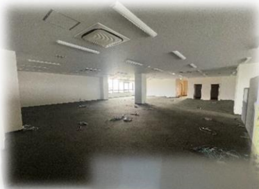
▼空室となっている燕庁舎2階
