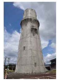
剥落防止ネットで覆われた 水道の塔
