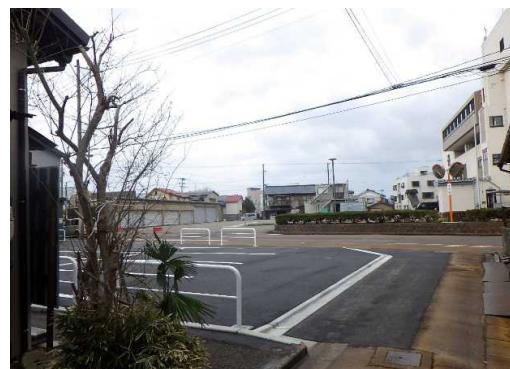
拡幅された北側道路
