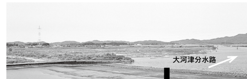
工事着手前状況 平成18年9月撮影
