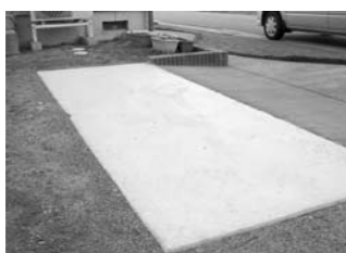
↑もともと合併浄化槽があったところにはコンクリートを敷きました。庭へつながるスロープにしました。
