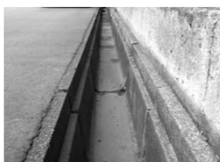
↑すっかり乾いた側溝には、ごみ一つ落ちていません。下水道接続前は常に水が溜まり、ポウフラが発生していました。今はネコが散歩道になっているそうです。
