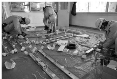
点灯式前に行われたLED照明の交換作業。蛍光灯を天井から外し、100ボルトの交流を43ボルトの直流に変換するコンバーターを取り付けます。ランプ以外は既存の設備をそのまま大切に使用しました。
