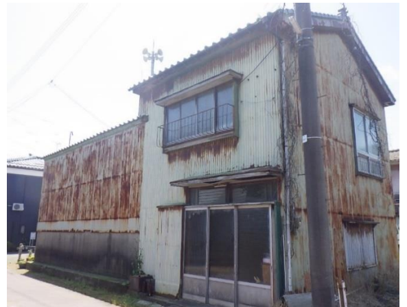
外側のトタンを外すと、土蔵の外壁が現れます！
