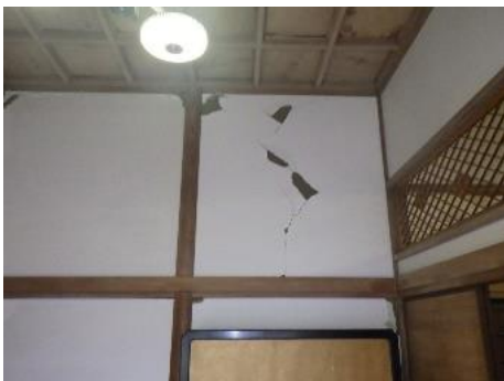
令和6年能登半島地震の影響で、壁の一部にひび割れや剥がれあり。
